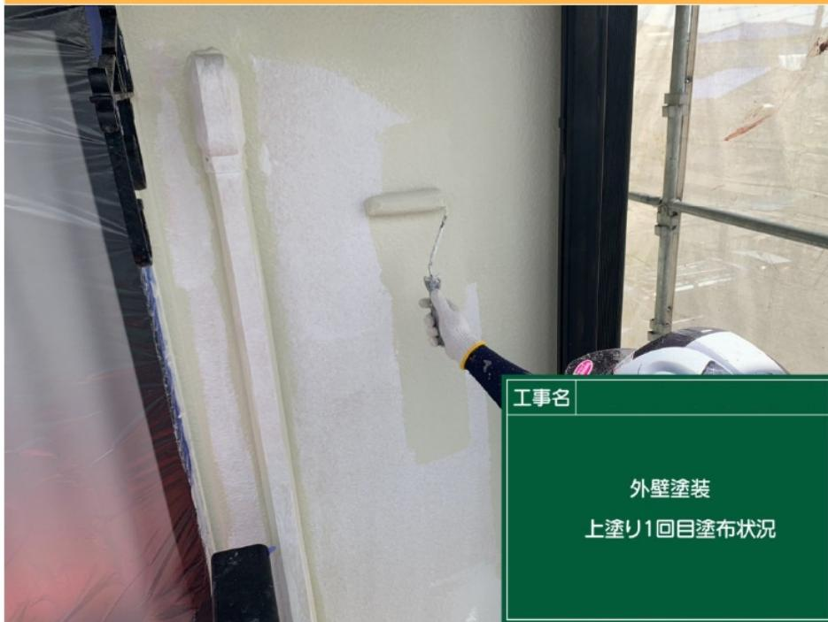
上塗り材1回目を塗布する工程です。刷毛・ローラーを使用して塗膜に厚みを持たせます。
